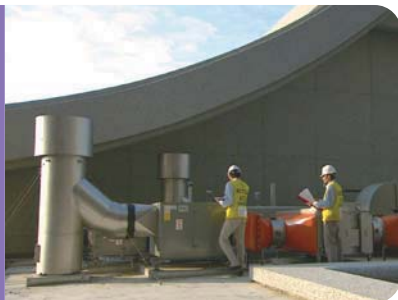
產業通風工程
