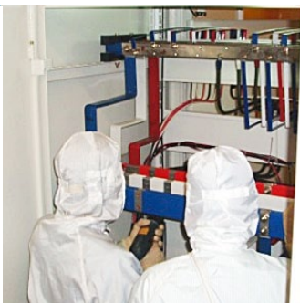
機電空調工程
